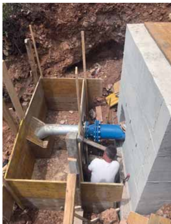
Izvođenje radova na spajanju dovodnog cjevovoda na Pelješcu s podmorskim cjevovodom za Mljet
