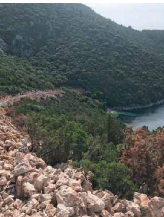
Uvala Kupjenova na Pelješcu – lokacija spoja dovodnog cjevovoda na Pelješcu s podmorskim cjevovodom za Mljet
